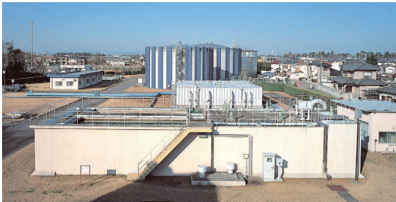
図3-4 浄水された水を受水し、各家庭に配水するための守谷配水場。
